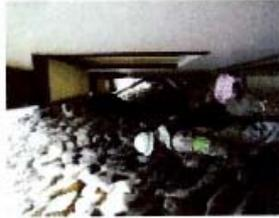
全体の被害状況を把握しながら、宅地の平面図、被害箇所の断面図を調査票に記入していきます。
