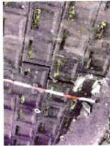
各被害状況（亀裂の幅、傾き状況など）を調査し、被害程度に応じて採点をを行い、宅地の被害程度を評価していきます。
