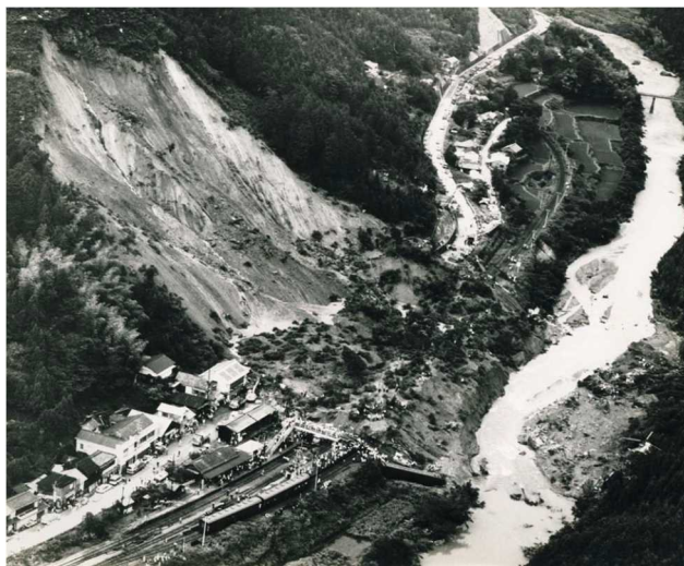
写真 1 追廻山の山腹崩壊（繁藤災害）
