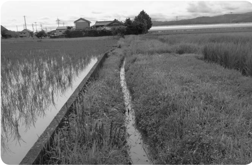
未整備の水路
