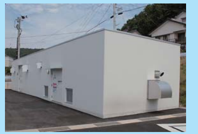
▲自家発電システム
