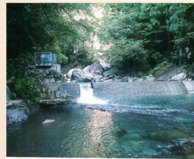
▲清爪大井の取水堰
