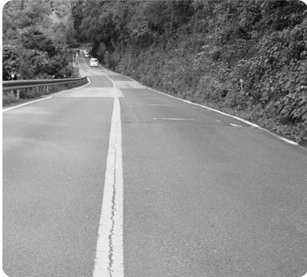
国道195号(杉田-橋川野)
