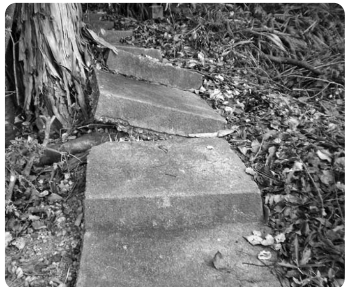
崩れた「はか山」の階段
