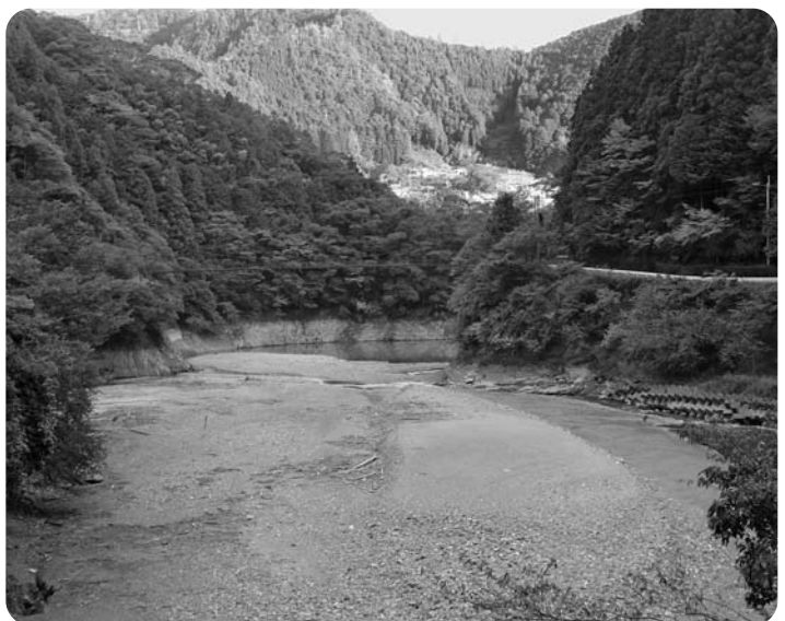
土砂の堆積した河床
