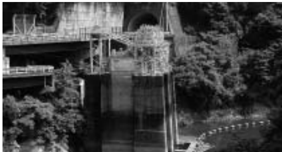
▲永瀬発電所取水口
