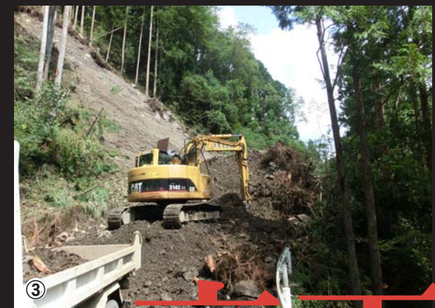
①豪雨により土砂崩れが発生した林道亀ヶ峠線（物部町）。大量の土砂や倒木が道路をふさいでいる。さらに、雨水が路面を流れている②豪雨の最中には、川のように水が道路を流れた③少しでも早く通行できるように道路をふさぐ土砂を取り除く作業が急がれた
