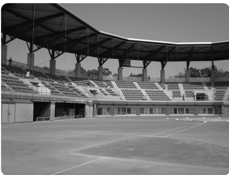
劣化が進んだ人工芝
