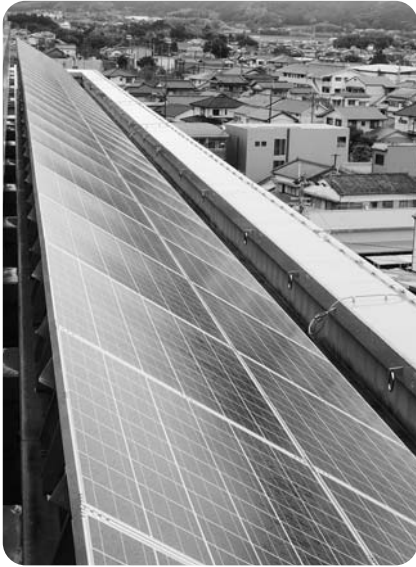
市役所屋上の太陽光発電
