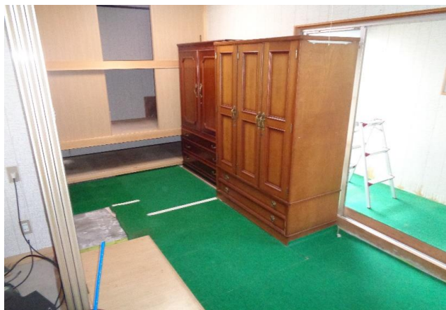
1階 土間造り洋間
