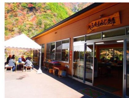
べふ峡休憩所
