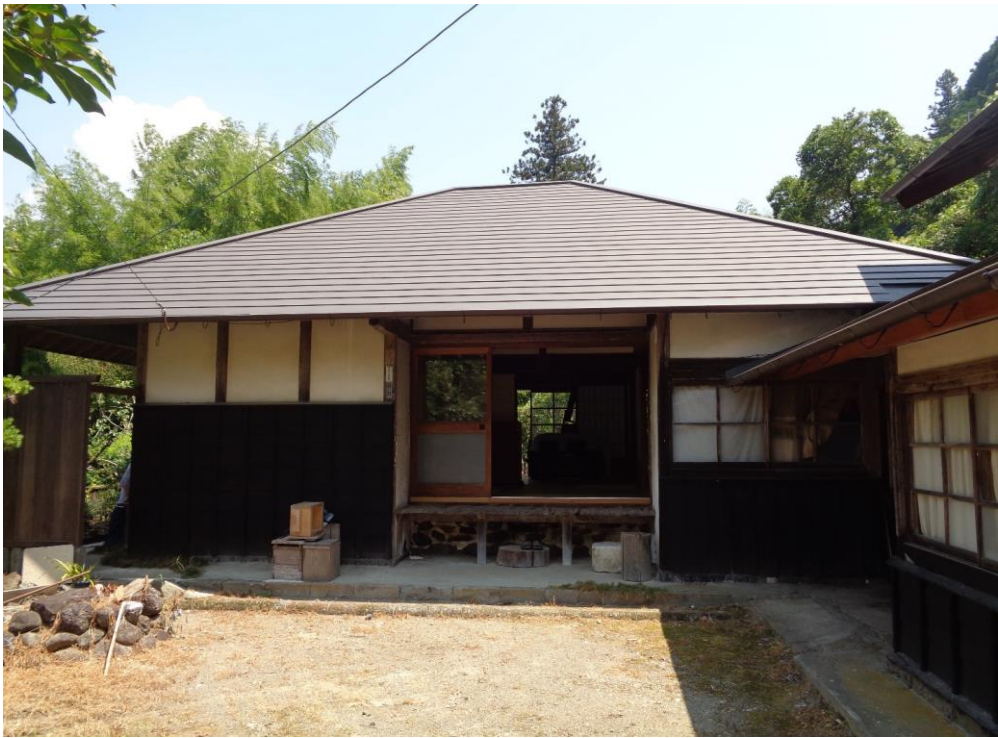
真夏でも涼しい風が通り抜ける古民家。縁側から物部川を望めます。 主の建物は耐震補強工事实施済み。
