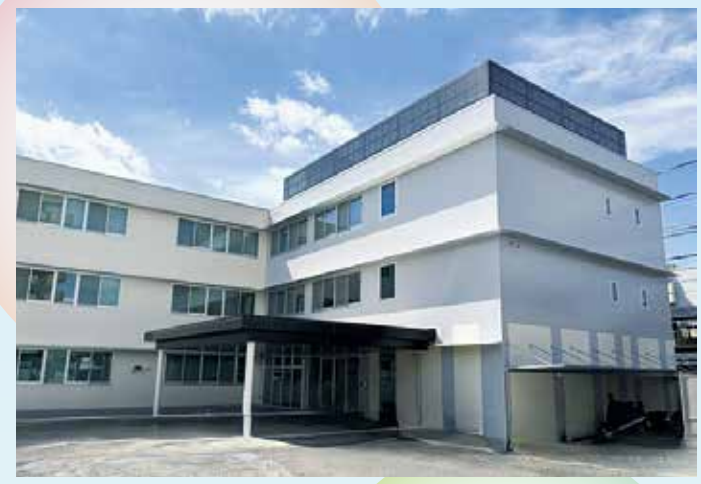
新西庁舎の外観
