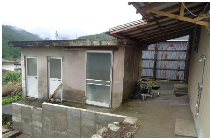
差し掛けとコンクリート造り建物
