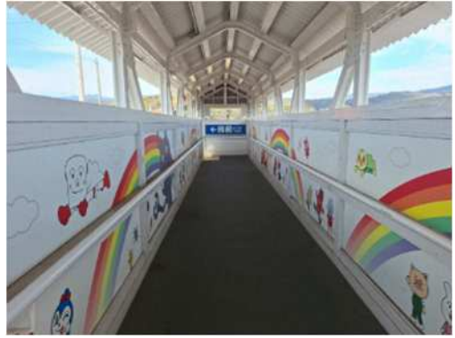
図 7-6.現在の連絡通路
