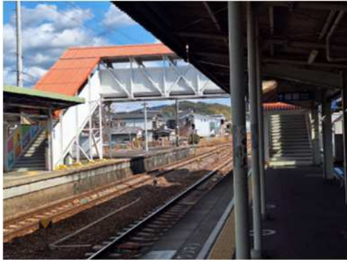
図 7-5.現在の連絡通路
