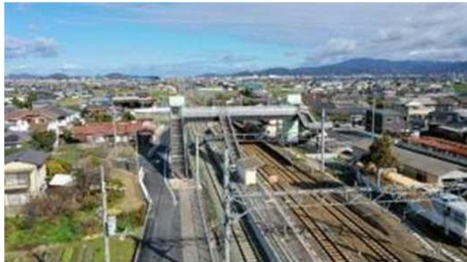
（自由通路及び周辺全景）
