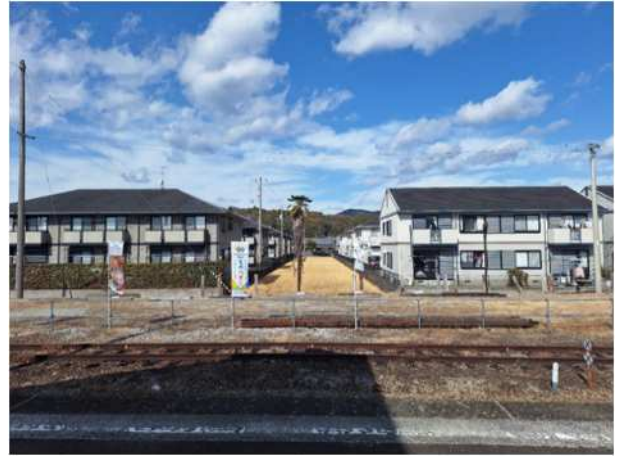
図 5-22.北駅前広場未整備 撮影方向② (JR 土佐山田駅より北方向)
