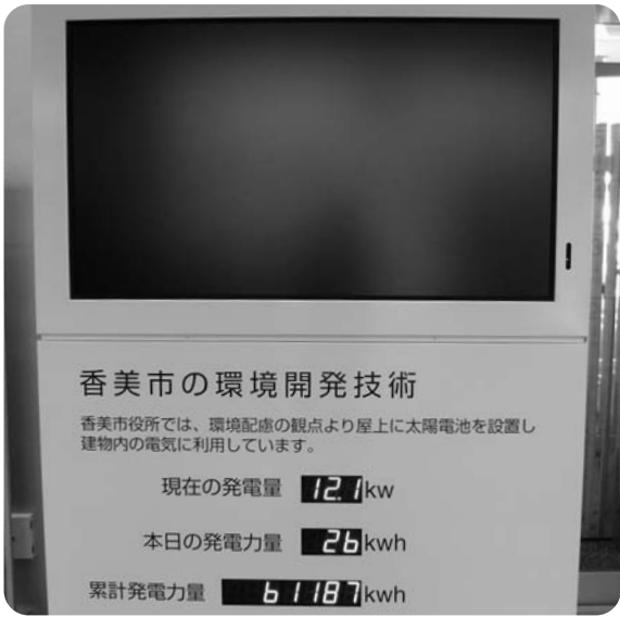
庁舎1Fロビーの太陽光発電掲示板
