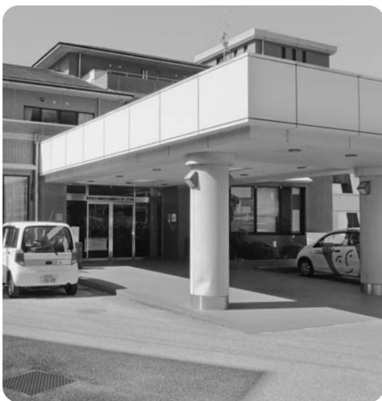
なくてはならない施設「こづみ」
