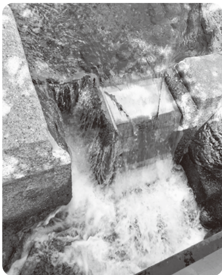
大栃水源取水口
