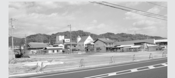
▲消防庁舎建設現場
