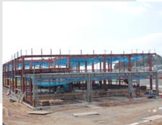
建設中の給食センター ▶
