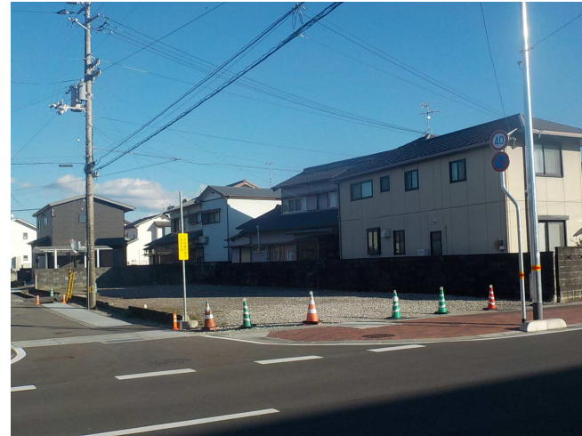
北西から南東方向
