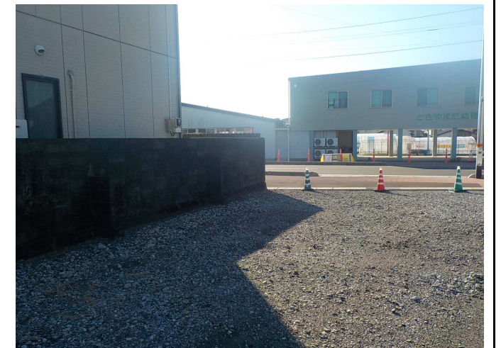
中央部から西南西方向
