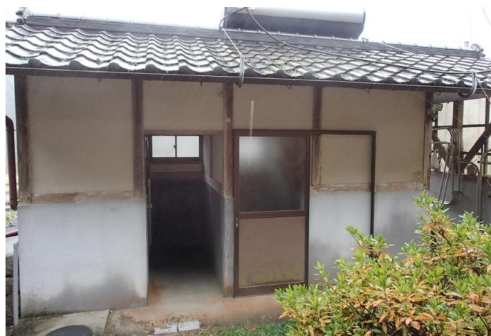
トイレ風呂外観
