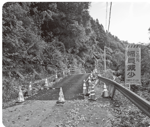
有瀬の仮設橋
