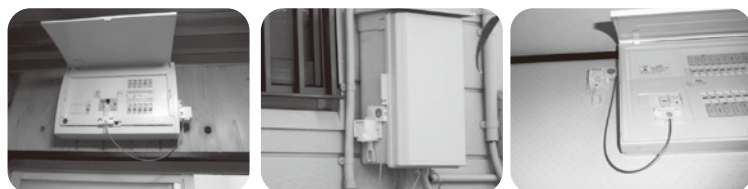
感震ブレイカーの取り付け例
