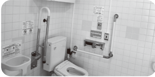
変更後の市営バス大栃駅トイレ
