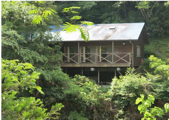
▲改修予定の大型バンガロー
