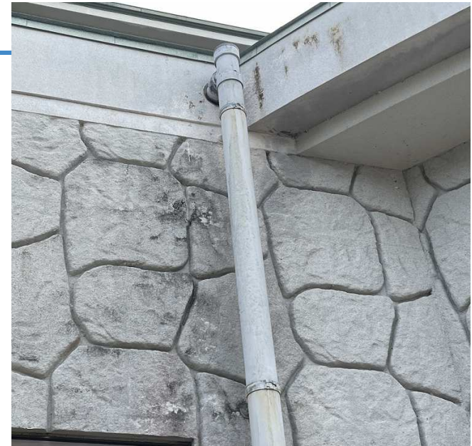
錆びの激しい外灯
