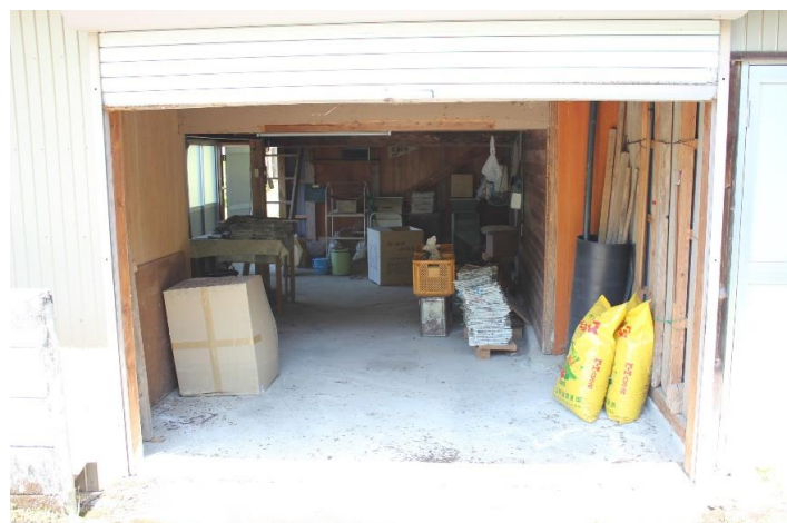
シャッター付の土間(物置)
