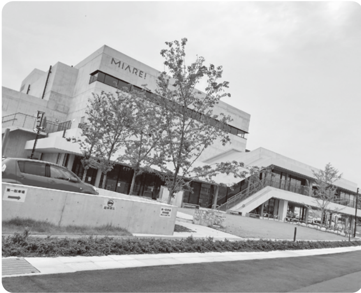
南国市地域交流センターMIARE! (みあーれ！)
