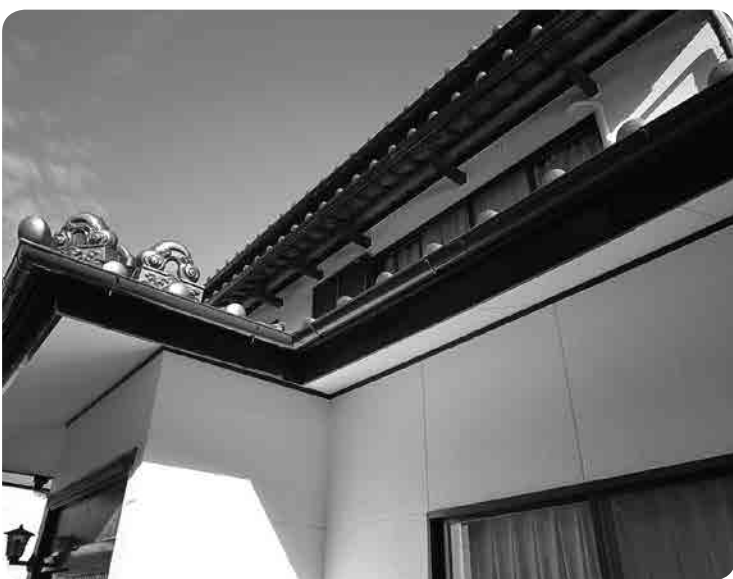
屋根等の塗装も補助対象です
