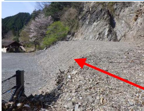
旧落石防護柵が土砂で埋没しており、上からの土砂を防護することができない状態で、危険である。土砂を取り除く必要がある。
