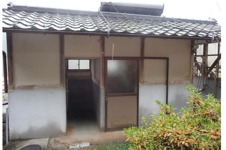
トイレ風呂外観
