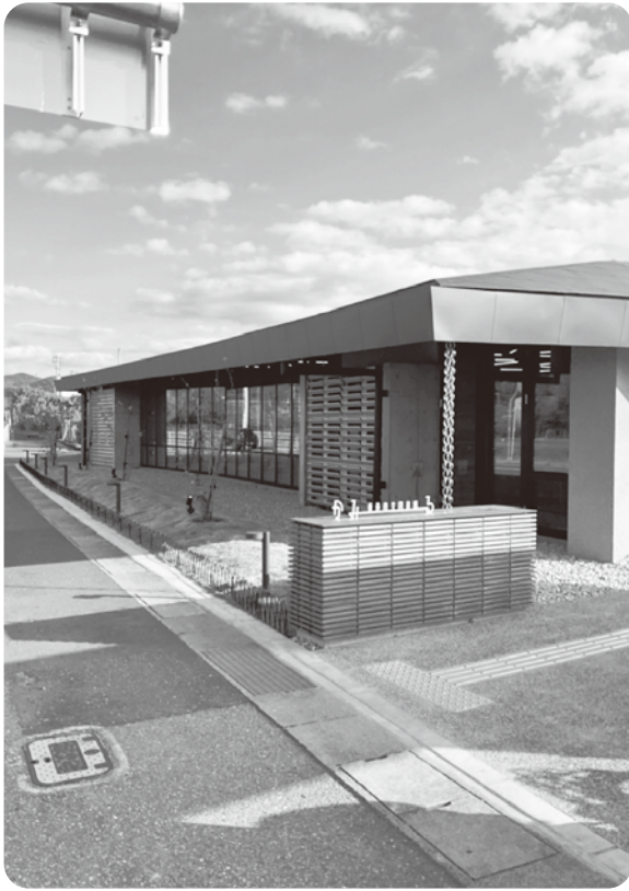
図書館（かみーる）側溝
