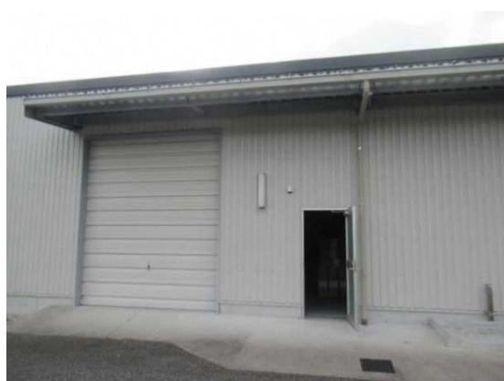
図 2.10 防災備蓄倉庫第2倉庫の外観
