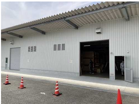
図 2.2 防災備蓄倉庫の外観
