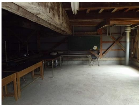
①床下倉庫：柱や壁に異常がないか
