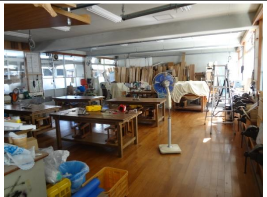
②各部屋：天井や照明に異常がないか
