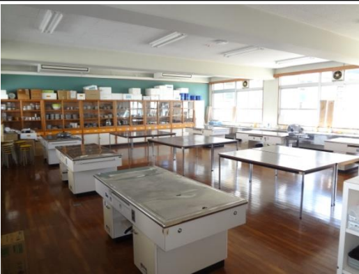
①家庭科室：ガス臭くないか
