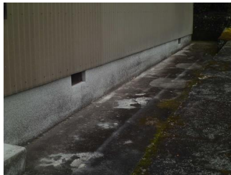
②基礎に異常がないか
