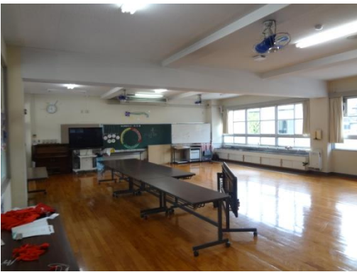
①食堂：天井や照明に異常がないか
