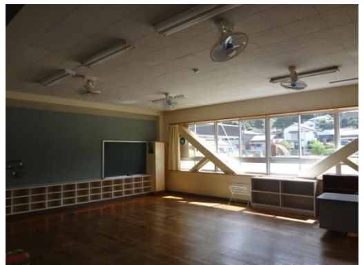
②各教室：天井や照明に異常がないか
