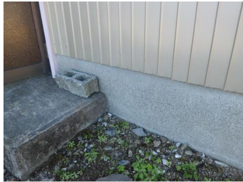
②基礎に異常がないか
