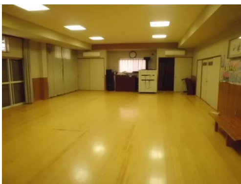
①集会室：ガラスの割れはないか、扉のゆがみがないか確認
