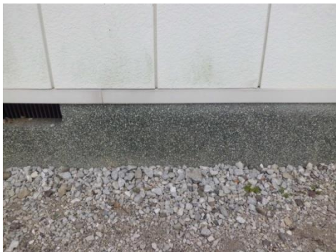
③基礎にひび割れなどの異常がないか
