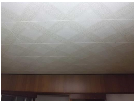
③集会室：天井に異常がないか
