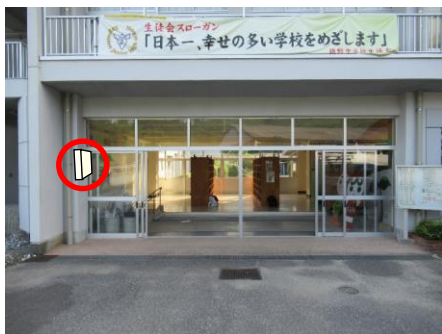
防災カギボックス設置予定場所
