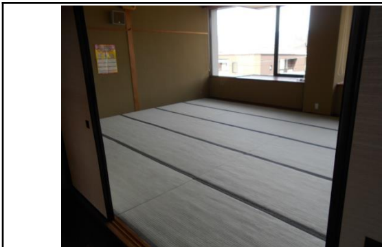
① 3階研修室：ガラスの割れはないか、扉のゆがみがないか
