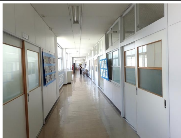
①廊下・教室：窓ガラスに割れはないか、天井などの落下はないか確認
