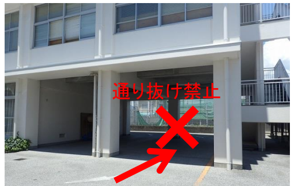
③ピロティ 窓ガラスの割れ、柱にヒビが入っていないか、折れていないか確認する
