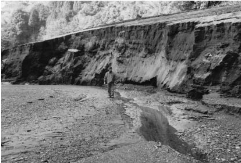
▲永瀬ダム湖に堆積した大量のへどろ（平成19年撮影） 段差になっている部分には、5 m以上のへどろが堆積しています。（※写真中央に立っている人と比べると、その量の多さがわかります）
