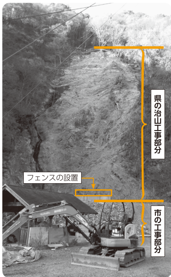
べふ峡温泉トイレ北側の落石工事現場
