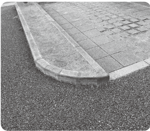
本庁駐車場の縁石
