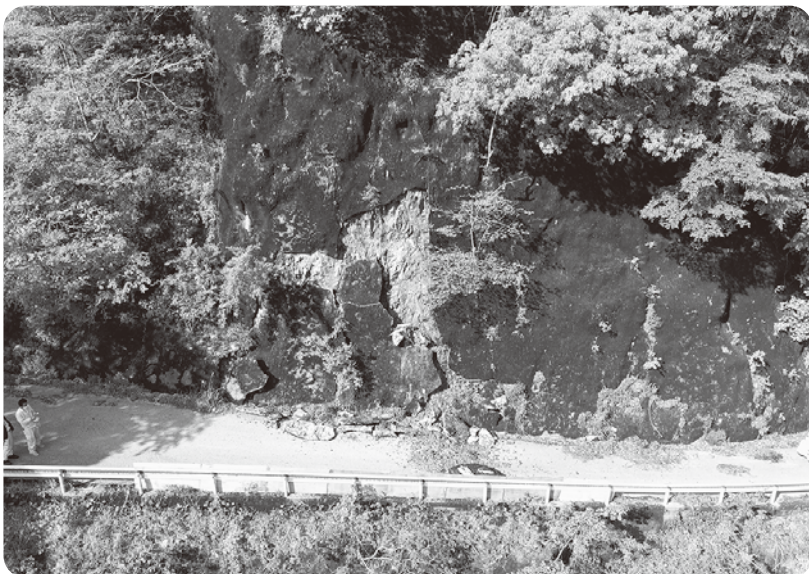
根木屋の崩落現場
