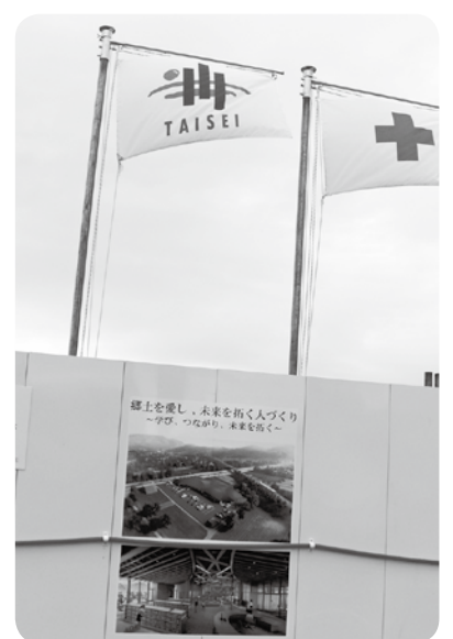
新図書館の工事現場
