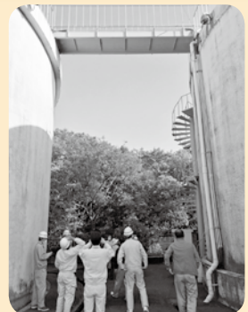
八王子配水池
