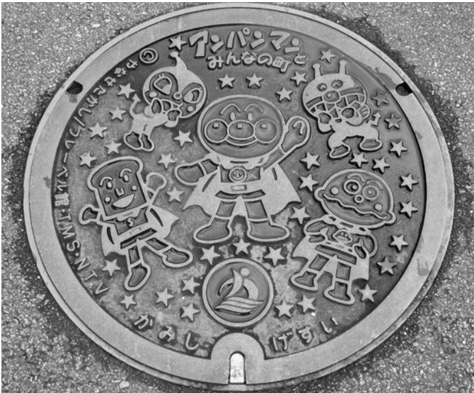
マンホールポンプ
